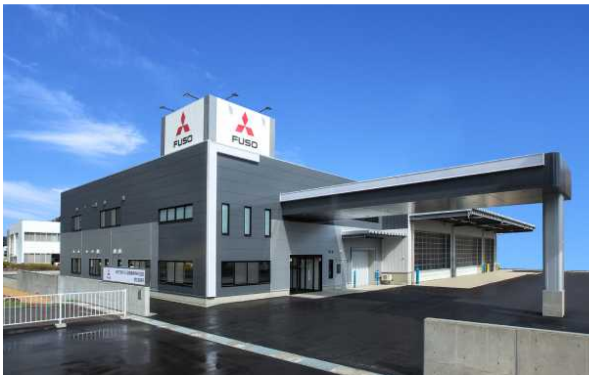
全面リニューアルした岩手ふそう 県北営業所
